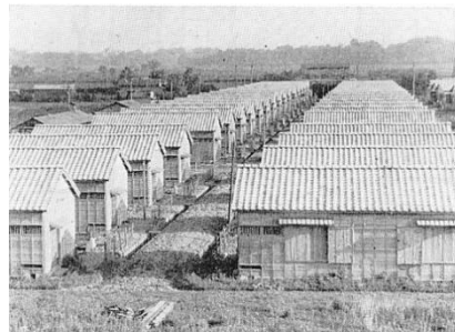
図1-30 応急簡易住宅 24
