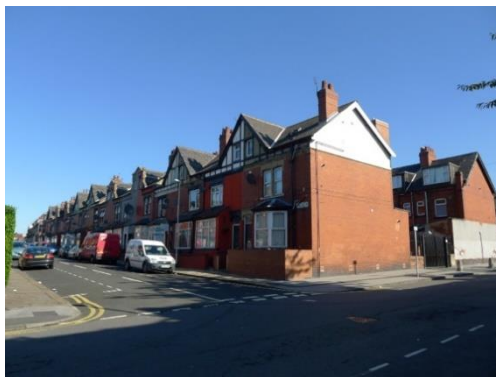
図1-13 イギリスに今も残る棟割長屋（Back to Backs）（著者撮影）
