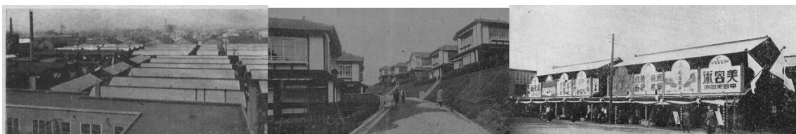
図1-22 東京市営（左より月島住宅、真砂町住宅、本村町住宅） 13
