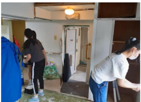
シェアハウスとして入居者自身でDIYしている様子
